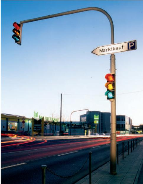
**Zylindrischer Signalmast mit kreisförmigem Ausleger, Nürnberg**
