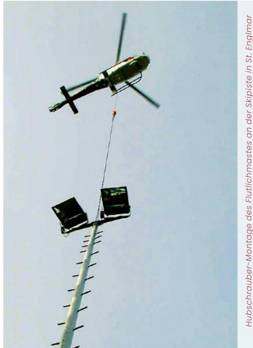
Hubschrauber-Montage des Flutlichtmastes an der Skipiste in St. Englmar
