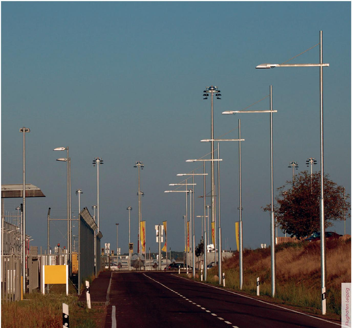
Der zylindrisch abgesetzte Stahllichtmast ist gekümpelt und umlaufend verschweißt. Der Stahl hat eine Mindestqualität nach S235 JR und ist innen und außen feuerverzinkt nach DIN EN ISO 1461.
