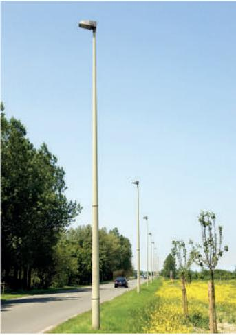
*GFK-Masten in unterschiedlichen Farben mit Aufsatzleuchten in Frankreich*
