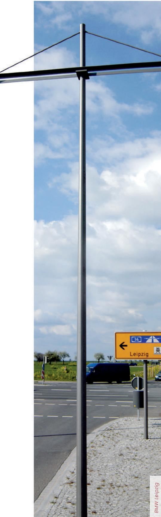
Der konisch runde Lichtmast besteht aus einem umgeformten und längsnahtgeschweißten Stahlblech, welches mit einer Stahlmindestqualität von
